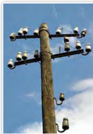
Der noch erhaltene Telefonmast
